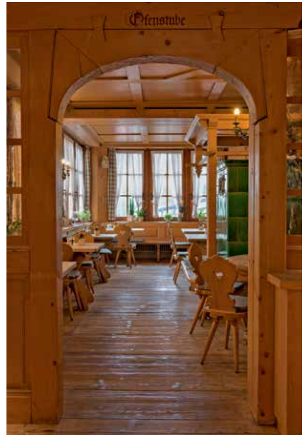
Die Durchgänge in die Frühstückstube beziehungsweise Ofenstube zeigen zwei unterschiedliche Arten, wie man früher in Schwarzwaldhäusern Türbögen abgefangen hat
