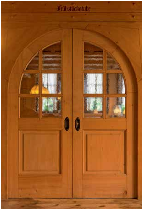
Die Durchgänge in die Frühstückstube beziehungsweise Ofenstube zeigen zwei unterschiedliche Arten, wie man früher in Schwarzwaldhäusern Türbögen abgefangen hat
